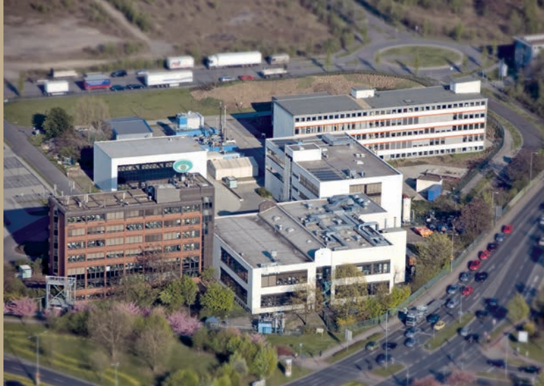
Gebäudekomplex Fraunhofer UMSICHT
