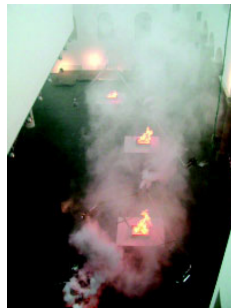
Entrauchungsüberprüfung in einem Atrium: Wärme- und Nebelquellen
