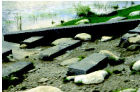
Hochwasserschutzmaßnahmen am Rhein bei Hilden
