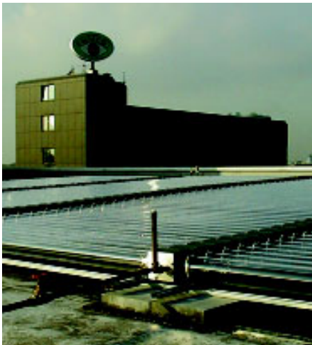
Vakuumröhrenkollektorfeld
