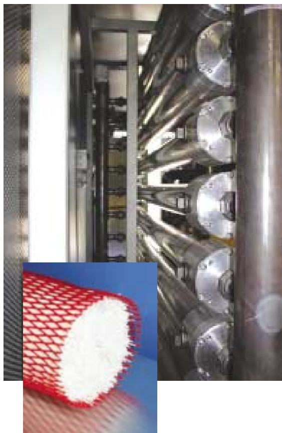
In der Membrananlage reichert eine Vielzahl von Hohlfasermembranen (siehe Ausschnitt) Luft mit Sauerstoff an
