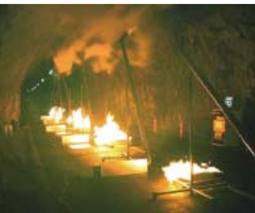
Entrauchungsüberprüfung in einem Tunnel
