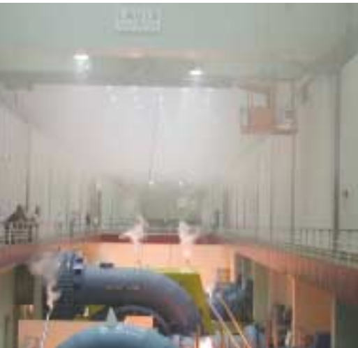
Entrauchungsüberprüfung in einer Kraftwerkskaverne
