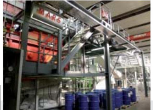
Die MARS®-Anlage: zu sehen sind die neue Fördertechnik (weiß), die Leitung der Wasserkühlung für den Rost (grün) sowie der Feuerraum (rot)
