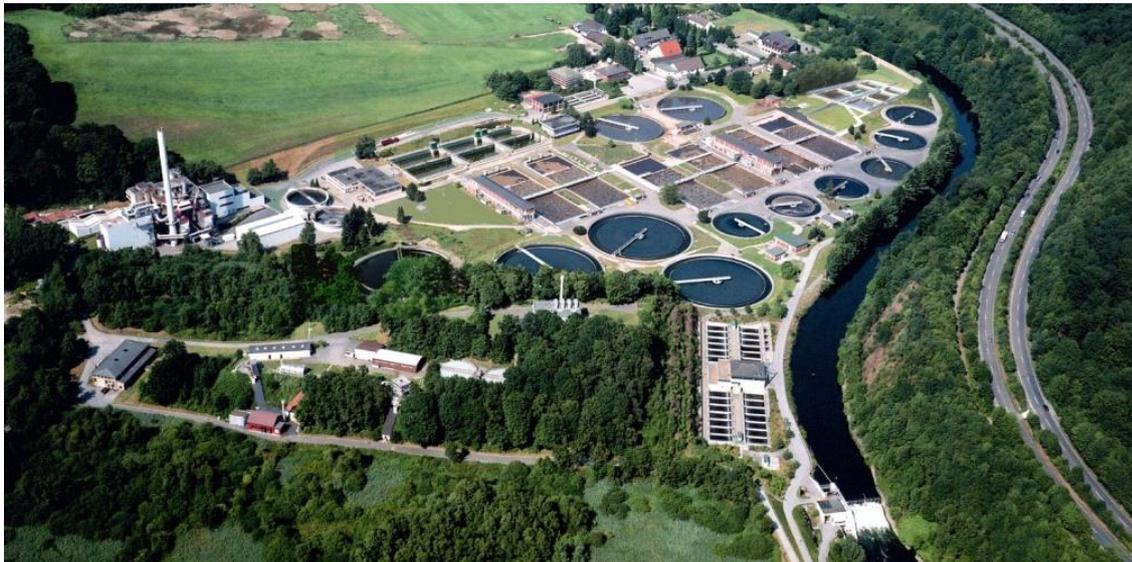
Abbildung 62: Kläranlage Buchenhofen mit Flockungsfiltration im Vordergrund
