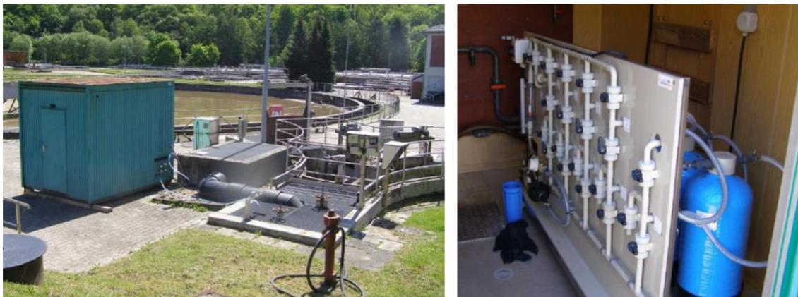
Abbildung 63: Containerstandort (links) mit 24 L Adsorbern (rechts) für das industrielle Abwasser
